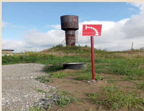
Пожарный водоем с. Кочневское
