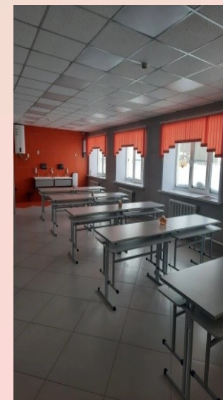
Аксарихинская СОШ-ремонт пищеблока
