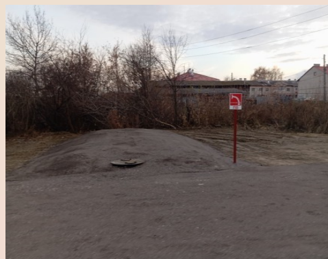
Пожарный водоем с. Обуховское
