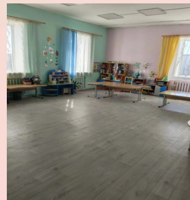
Баранниковский ДС-ремонт пола
