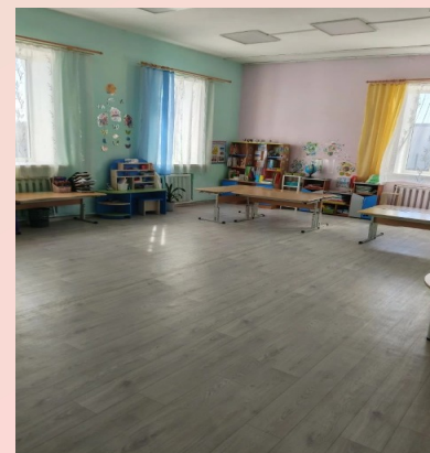
Баранниковский ДС-ремонт пола
