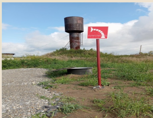
Пожарный водоем с. Кочневское
