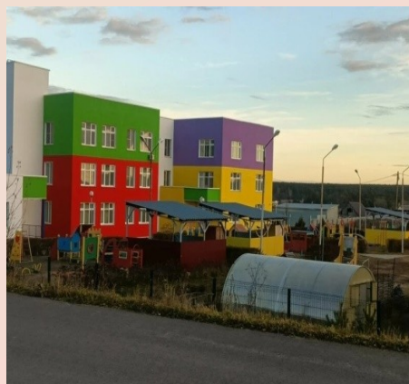
Обуховский детский сад №2-покраска фасадов
