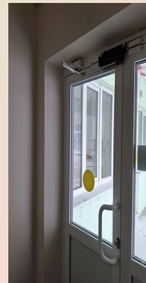
Галкинский ДС - ремонт тамбуров
