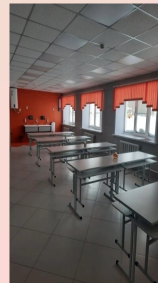
Аксарихинская СОШ-ремонт пищеблока
